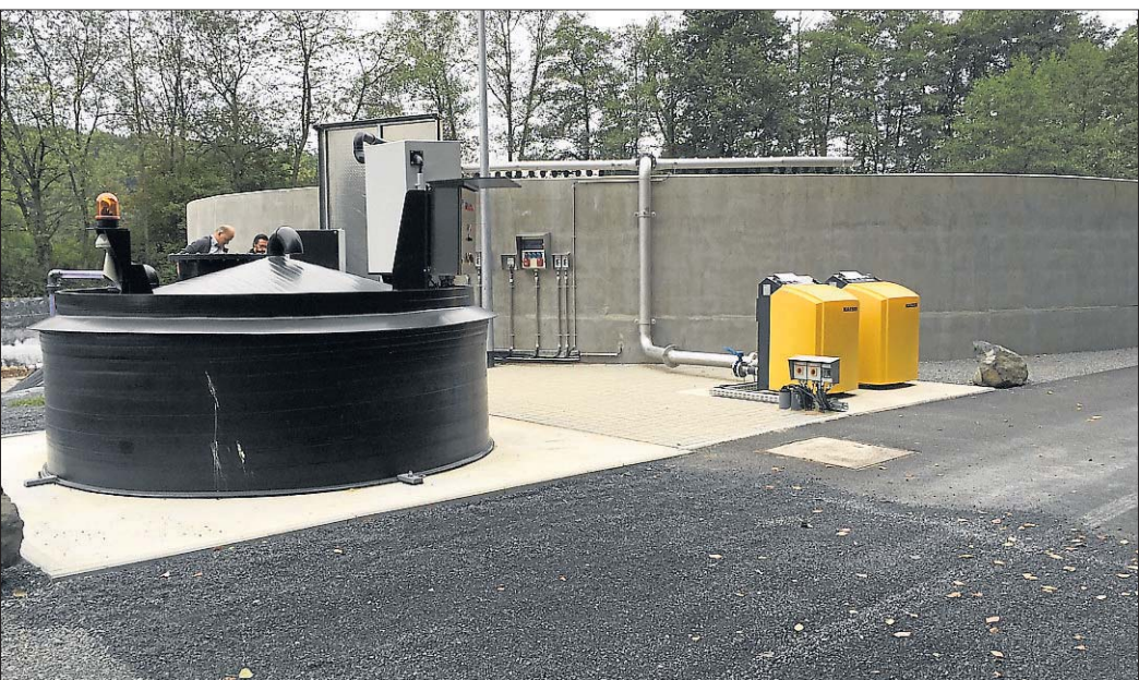
Die Kläranlage Rothemann wurde für zwei Millionen Euro runderneuert.
