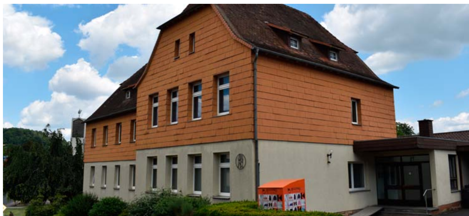
Die Alte Schule wird derzeit saniert.
